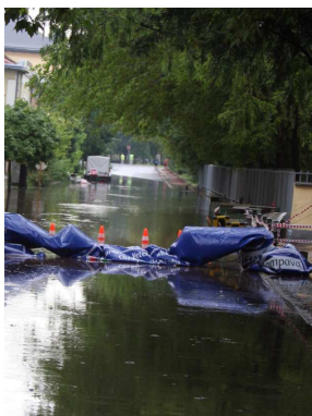
Chaos nach Sturm und Regen – Geherstrecke unter Wasser
